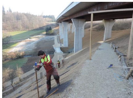
Aufforstung am Bahndamm
