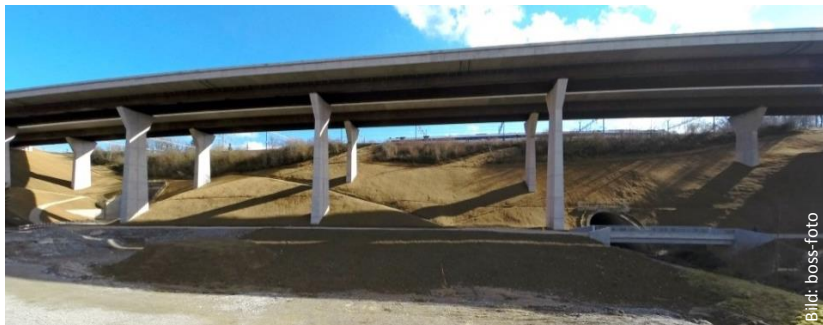
2013 neu erstellter Autobahnviadukt am Bahndamm
