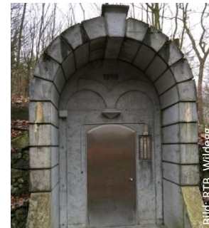
Der nachgebaute Torbogen zum Reservoir
