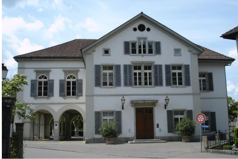
Alter Gemeindesaal Eingang und hinterer Teil Säulenhalle links
