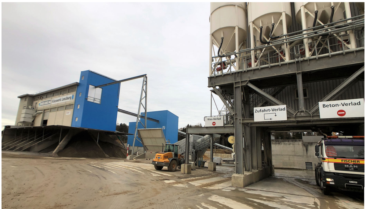
Abbildung 4.1.1-3 Bereich 2: Kiesverarbeitung (links) und Verladestation für Kies und Beton (rechts).
