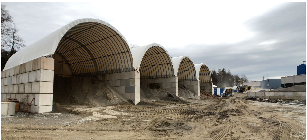
Abbildung 4.1.2-2 Bestehender Lagerstandort mit Schüttguthallen ähnlich der Ausführungsvariante der neuen Aufbereitungsanlage. Sicht auf Bereich 3.
