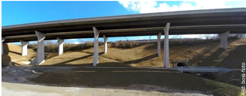
2013 neu erstellter Autobahnviadukt am Bahndamm
