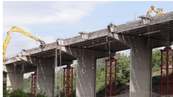
Abbruch des erneuerungsbedürftigen Viadukts 2011
