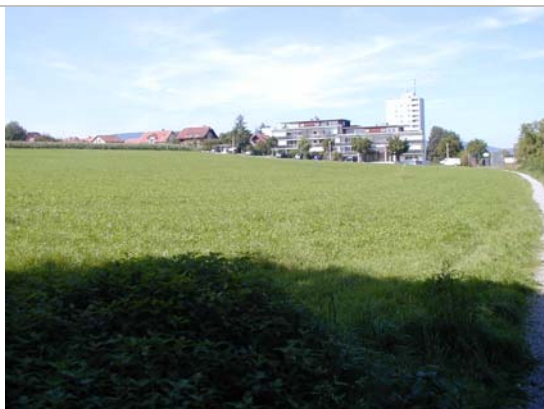
Blick Richtung Norden Hintergrund Ortsrand Niederlenz
