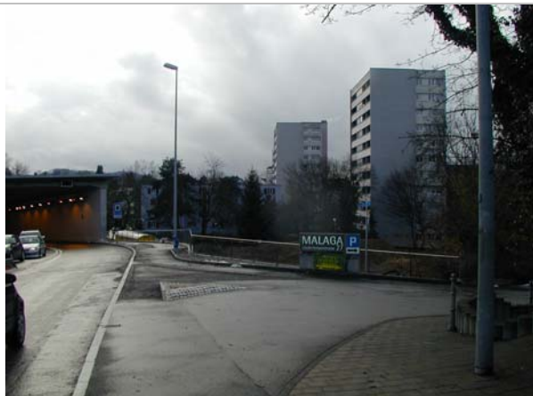
Blick Richtung Westen Ostportal Kernumfahrung und Einfahrt Parkhaus Malaga
